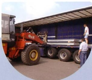
Entladung und Montage der Fahrzeugwaage mit Gabelstapler oder Radlader.
