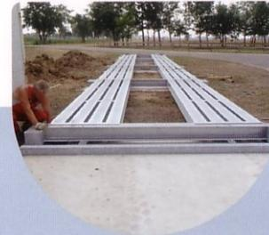
Die Transportsicherung an Wägebalken und Zellenkasten wird gelöst.
