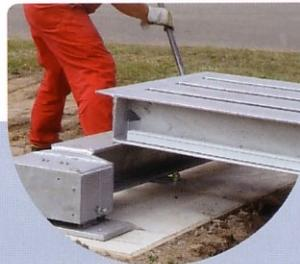
Der Wägebalken wird zur Fahrspur hin ausgerichtet.
