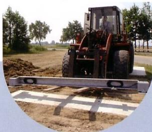
Einer der Wägebalken wird auf das Fundament gestellt und ausgerichtet.
